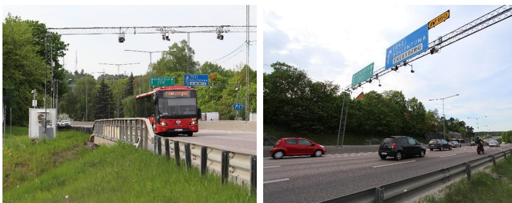
Figur 12. Kameraregistreringar av fordonsammansställning vid E18 i Mörby centrum. Södergående körfält t.v. och norrgående t.h (Facility Labs och SLB-analys [13]).
